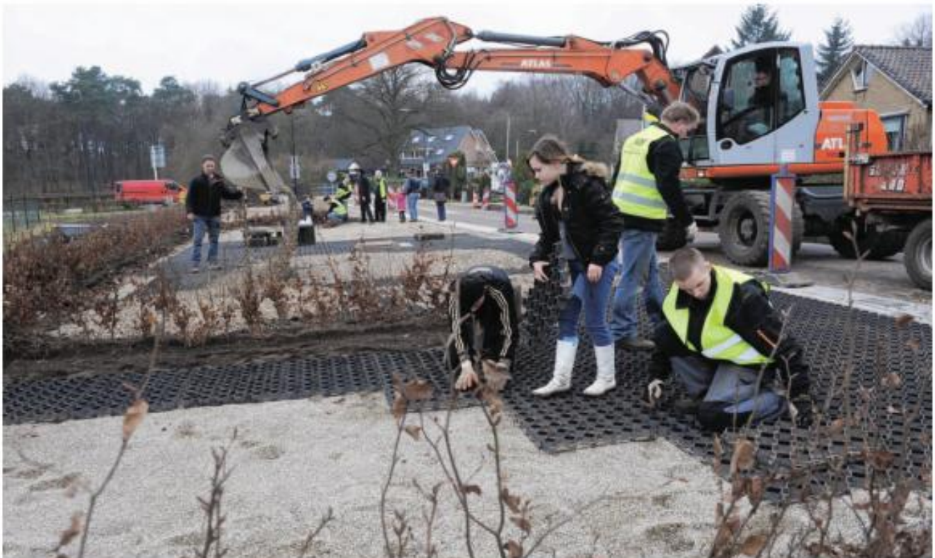
Een rommelig parkeerterrein wordt met vereende krachten omgezet in een nette entree van het dorp.
